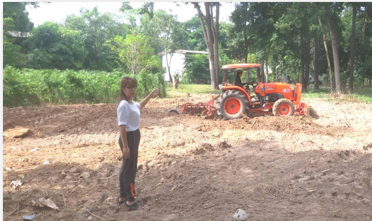
ภาพที่ 2.7 การไถดินเตรียมพื้นที่ทำแปลงปลูก
